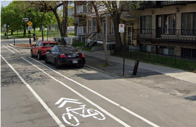
Figure 11. Bande cyclable unidirectionnelle avec bande de protection contre les emportières, Montréal
