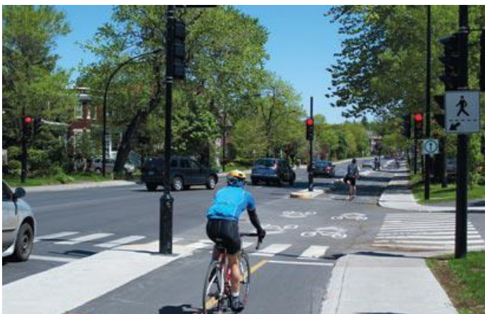
Figure 9. Piste cyclable dans l'emprise, séparée par bordure de béton
