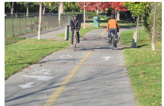
Figure 10. Piste cyclable unidirectionnelle surélevée et séparée par bordure
