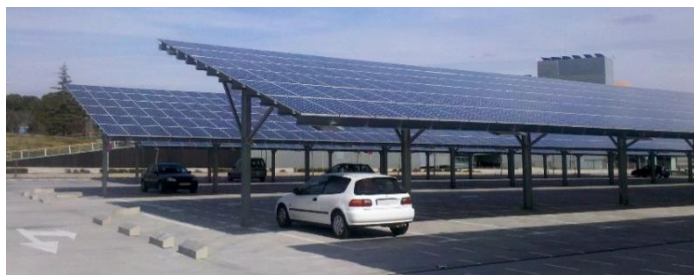
Figure 14. Recouvrement avec panneaux solaires
