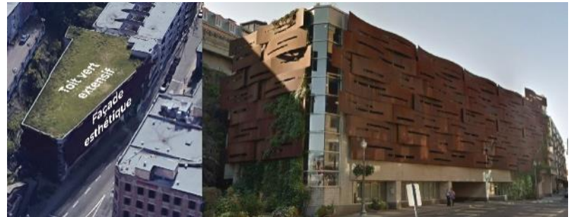
Figure 3. Stationnement étagé avec façade de qualité et toit vert
