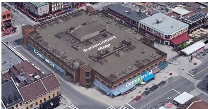
Figure 4. Stationnement étagé avec locaux commerciaux en rez-de-chaussée
