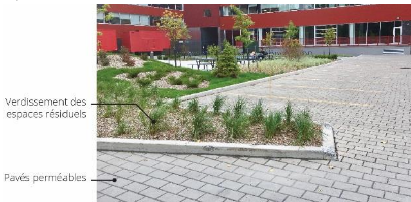
Figure 11. Pavés perméables et verdissement
