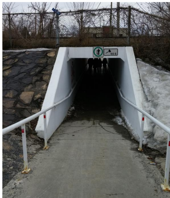
Figure 8 : Tunnel reliant l'avenue Saint-Charles et la rue Valois, Vaudreuil-Dorion
