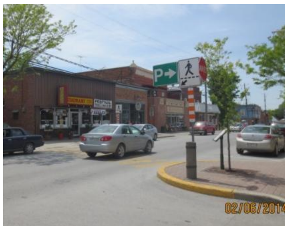
Figure 15 : Exemple d'avancées de trottoir au passage jaune, Bedford
