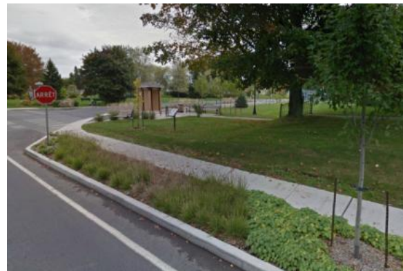
Figure 12 : Exemple d'îlot végétalisé à une intersection, Bromont
