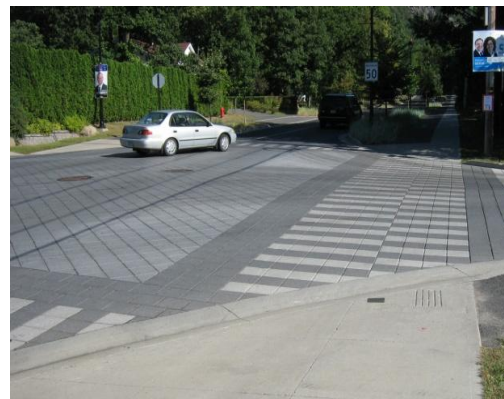
Figure 18 : Intersection surélevée et texturée, Mont-Saint-Hilaire
