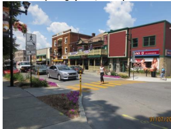
Figure 16 : Exemple d'avancées de trottoir au passage jaune, Granby
