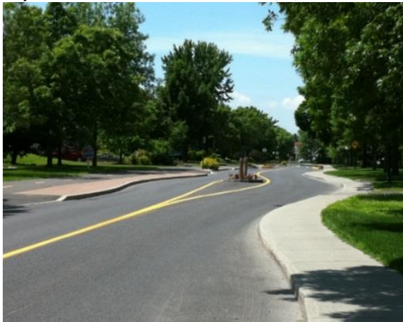
Figure 11 : Rue aménagée avec une chicane pour limiter la vitesse à 30 km/h, Candiac
