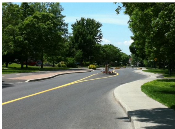
Figure 4 : Rue aménagée avec une chicane pour limiter la vitesse à 30 km/h, Candiac
