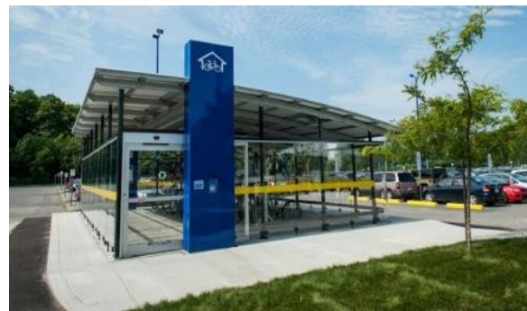
Figure 22 : Exemple d'abri-vélo, gare de Deux-Montagnes
