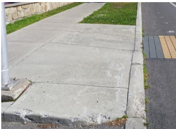
Figure 12 : Exemple de trottoir sans dénivelé, Châteauguay
