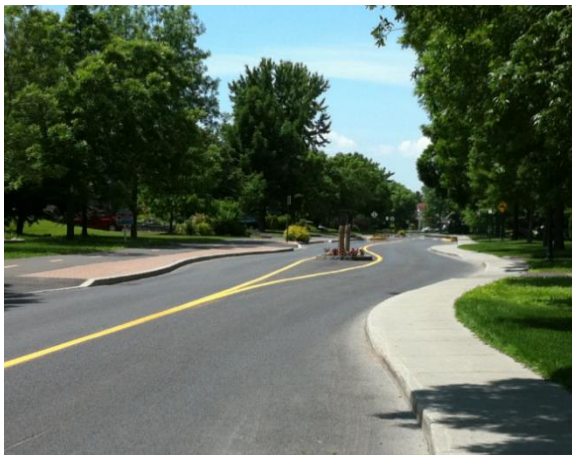
Figure 10 : Rue aménagée avec une chicane pour limiter la vitesse à 30 km/h, Candiac
