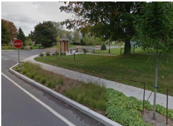
Figure 11 : Exemple d'îlot végétalisé à une intersection, Bromont
