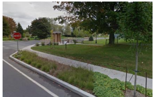
Figure 13 : Exemple d'îlot végétalisé à une intersection, Bromont
