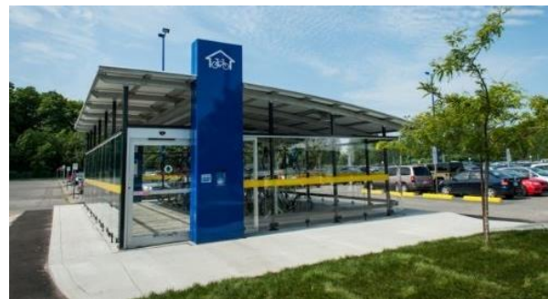
Figure 24 : Exemple d'abri-vélo, Deux-Montagnes
