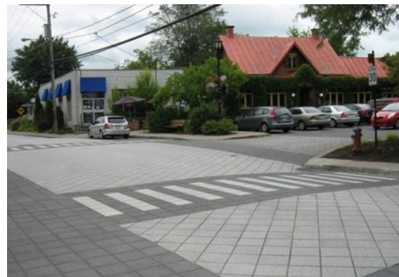
Figure 14 : Intersection surélevée et texturée à Beloeil – photo 1
