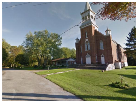
Figure 7 : Absence de trottoir devant l'Église de Saint-Armand
